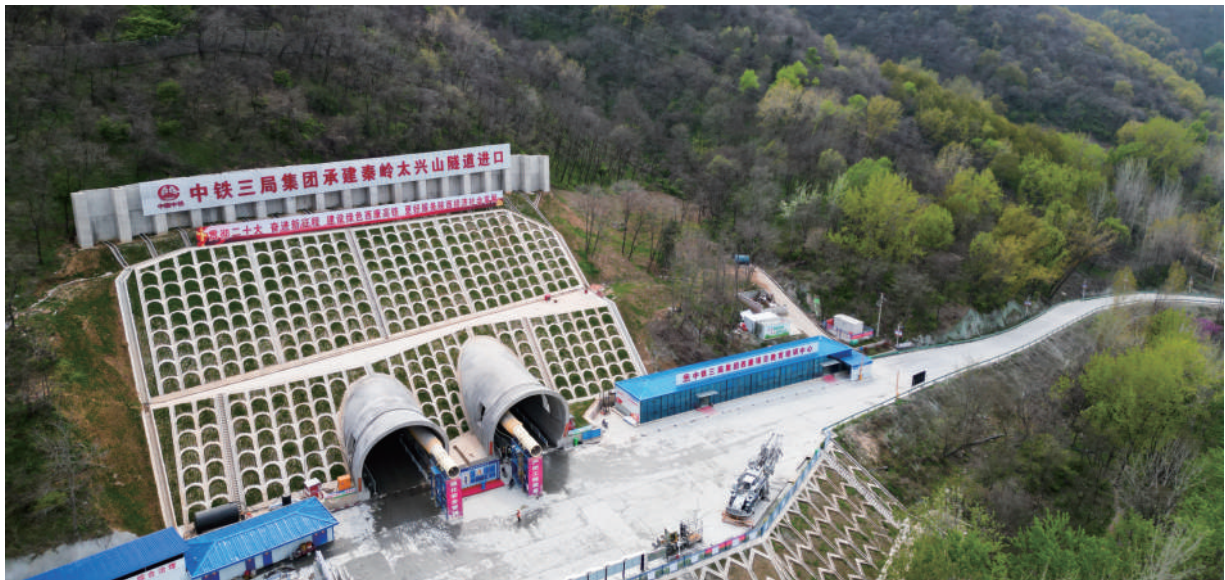
西康高铁秦岭天竺山隧道建设现场
